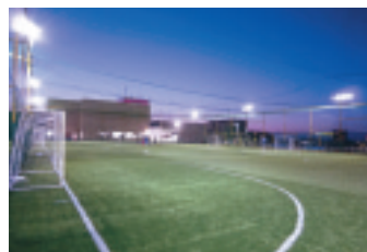
【スポーツ施設照明】 株式会社MESSEコーポレーション(フットサル場)
